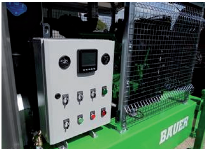
Pumpaggregat med SIL 9900 pumpstyrning. Styrningen är väderskyddad med en dörr skyddar instrumentpa-
